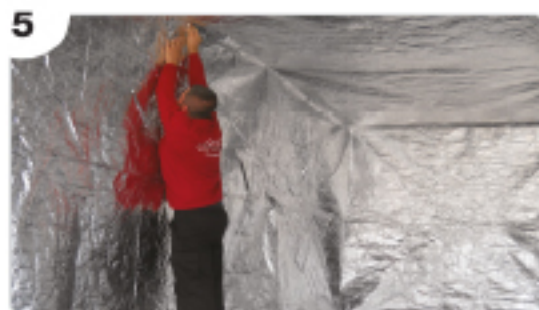
Colocación de imanes en los laterales del container
