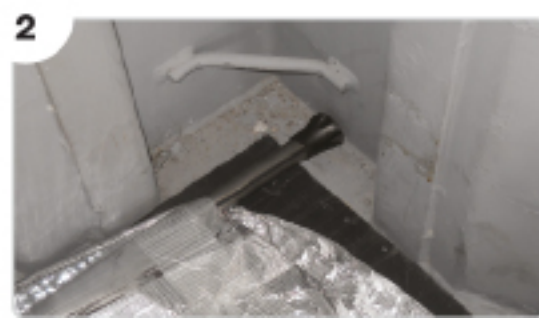
Colocación del tubo fijo en el canal trasero inferior
