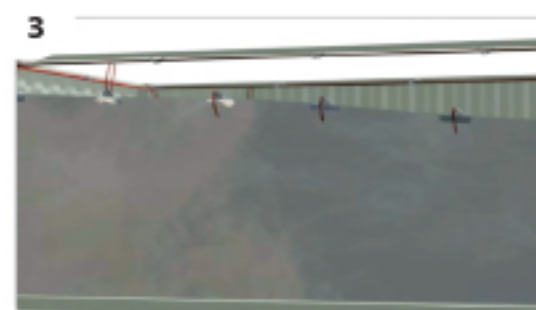
Sujeción de los cuatro tirantes y de las pinzas a la cinta perimetral
